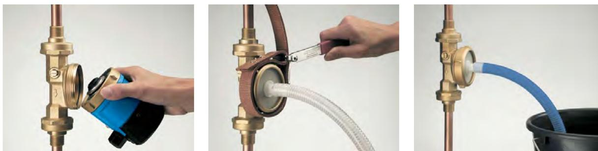
**Couper l'alimentation de** la pompe. Fermer l'arrivée d'eau du côté aspiration et pression vers la pompe. Par sécurité, nous vous recommandons aussi de fermer le robinet principal. Dévisser l'écrou prisonnier et ôter le moteur du carter de pompe.
